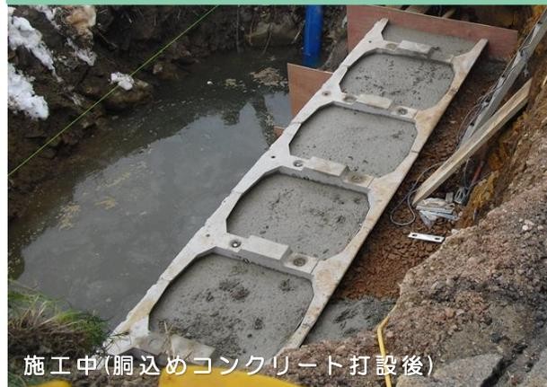
施工中(胴込めコンクリート打設後)
