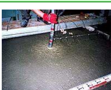
打設と振動の測定
