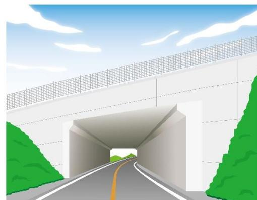
調査官が、ボックス内部で起点方から終点方を見通すと、路面がフラットではなく、波を打っているように見えます。水系を張って検測させたところ、カルバート内部は場所により16mmから203mmも沈下していることが判明しました。
